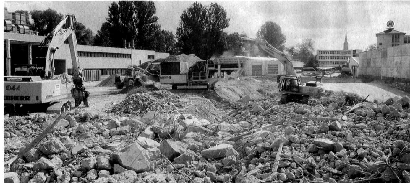
Mit den Abbruchgeräten von Steck bricht die Braig Abbruch GmbH die Kässbohrer Fahrzeugwerke in Ulm ab.
