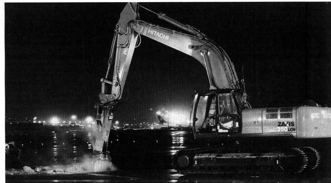
Ein starkes Gespann: Hitachi-Bagger von Kiesel mit dem Steck Abbruchhammer im Einsatz auf dem Frankfurter Flughafen.
