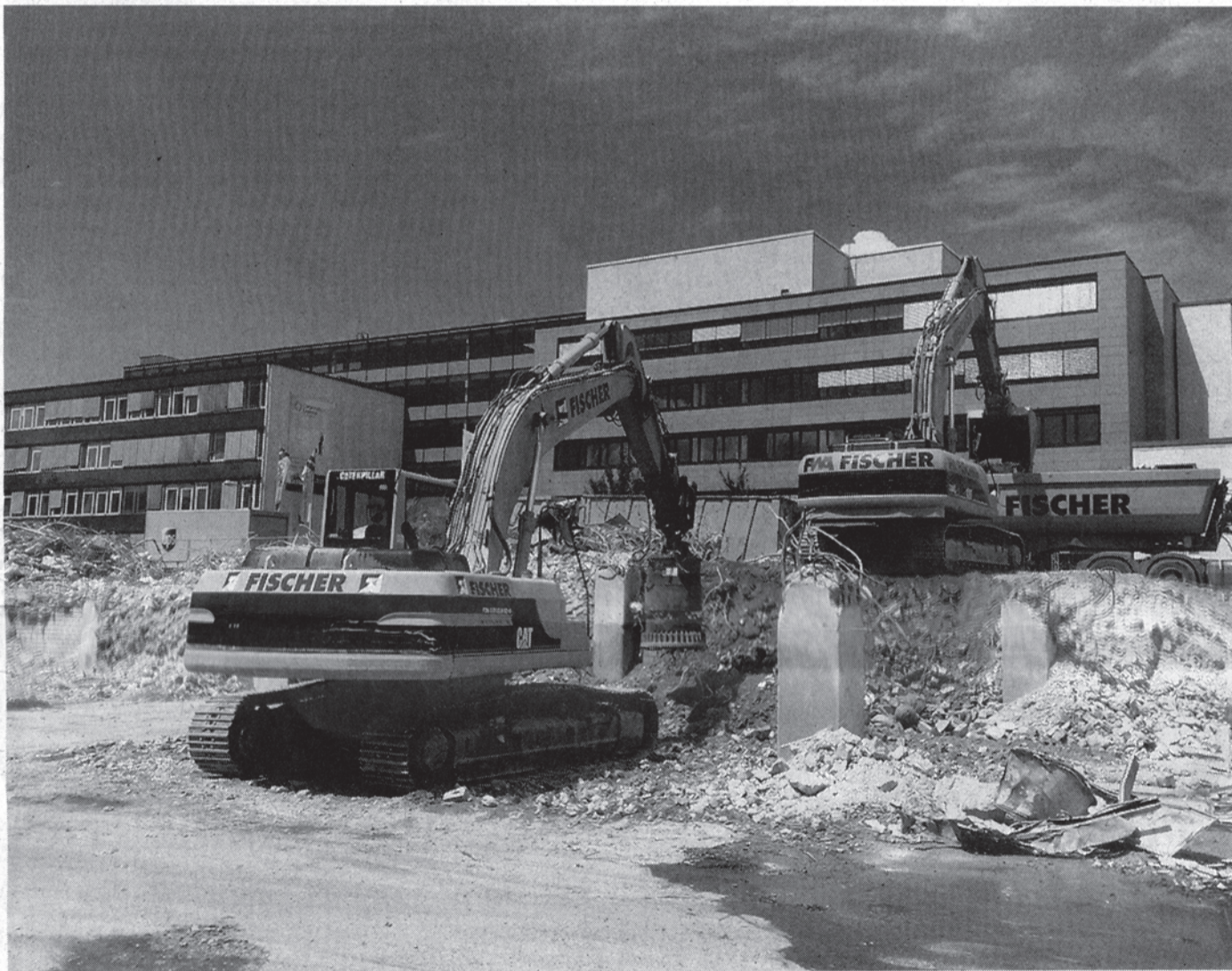
400 t Stahl konnte Fischer mit dem Lasthebemagneten von Steck einsammeln.
